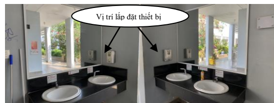
Hình 9: Thiết bị lắp đặt thực tế tại khu A.
